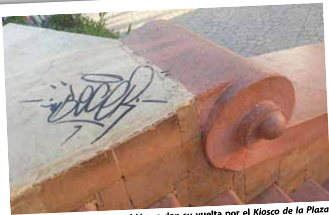
Pareciera que pandillas también se dan su vuelta por el Kiosco de la Plaza Zaragoza , a juzgar por las "pintas" que se observan en los barandales de cemento, sin que nadie lo impida ni elimine la evidencia de marcadores.
