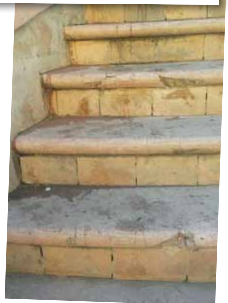
La otrora elegante escalinata del Kiosco Central muestra la huella de la indiferencia y del tiempo. ¿Qué hace falta para actuar?
